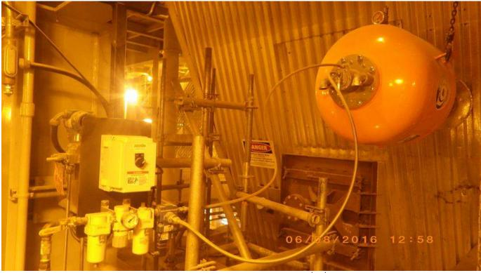
Photo 13 - Air Cannon In Hopper Under 2<sup>nd</sup>/3<sup>rd</sup> Pass
